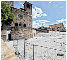
Am Bensheimer Marktplatz soll der Bauschutt weggeräumt werden. BILD: FUNCK
